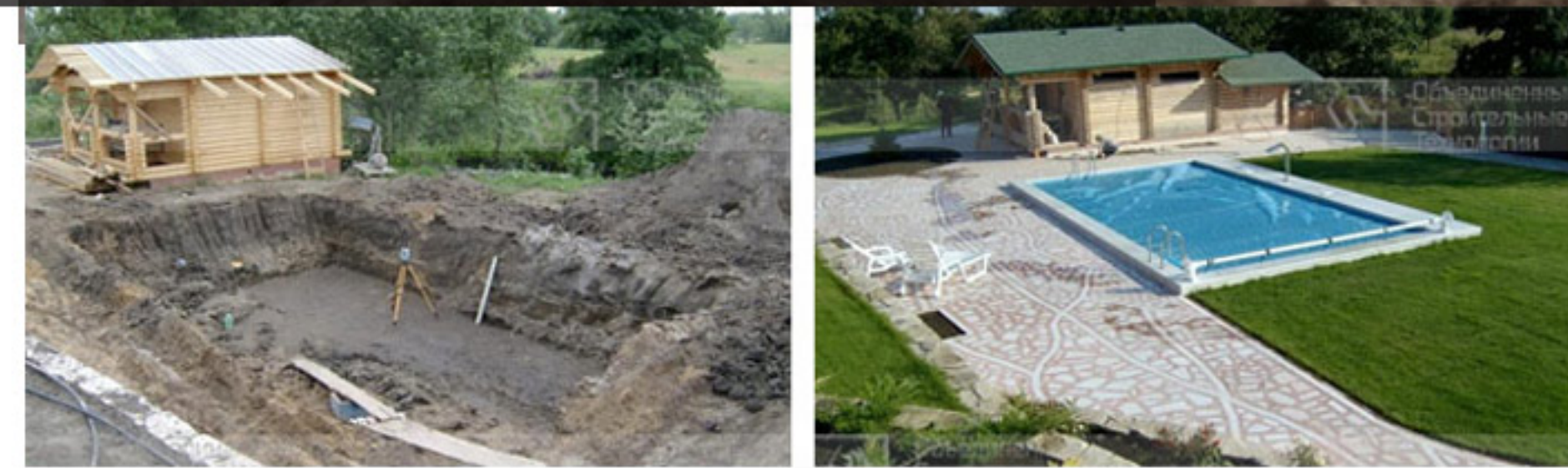
Фундаментные и свайные работы
